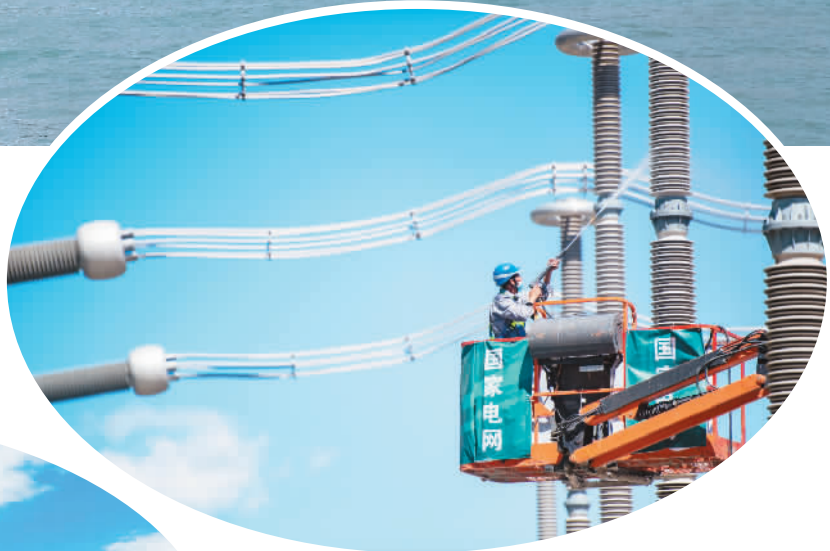
▲ 北京市延庆区八达岭镇里炮村，检修工人在张北柔性直流电网延庆换流站清洗绝缘立柱。
