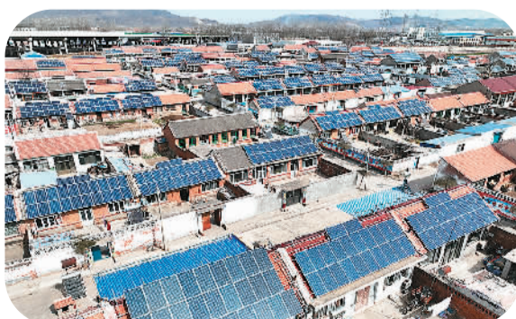
河北省玉田县孤树镇庄户村的屋顶分布式光伏面板（无人机照片）。新华社记者 牟宇摄
