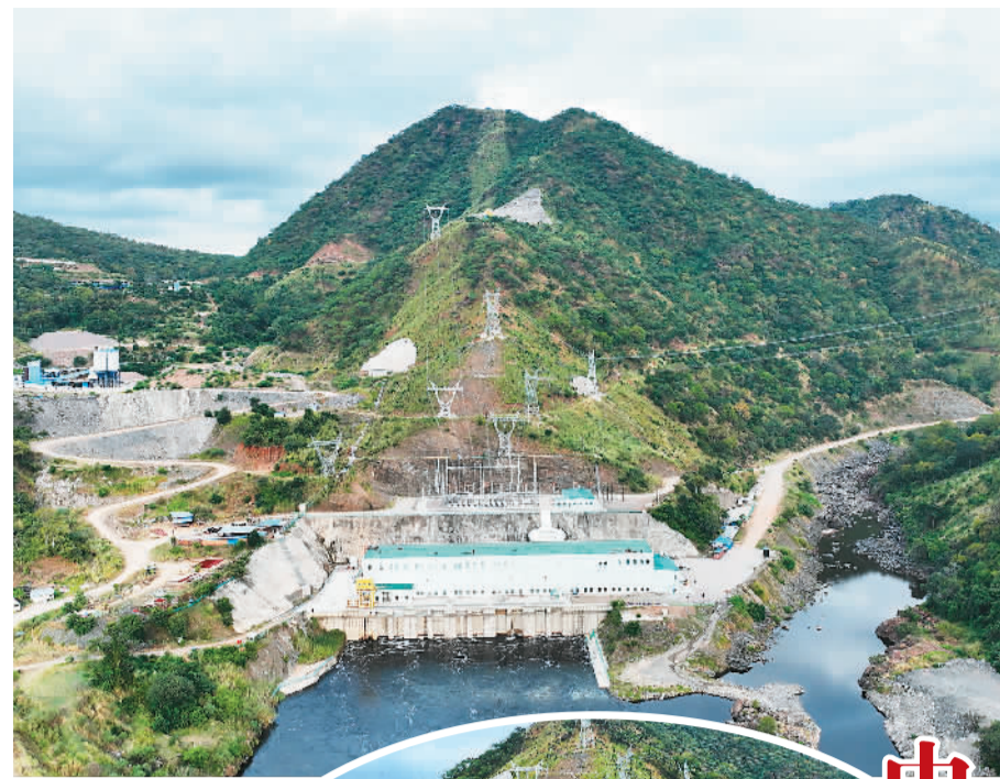
日前在赞比亚南方省航拍的下凯富峡水电站发电厂房。（新华社发）
