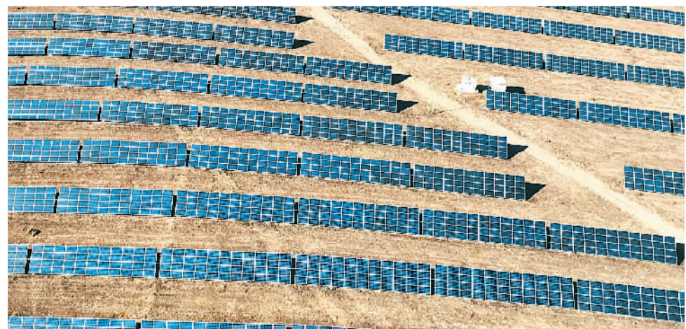
内蒙古自治区加快大型风光基地和源网荷储、风光制氢等场景项目建设,预计今年新增新能源并网规模超过2500万千瓦,力争今年底新能源并网装机规模达9000万千瓦以上。图为3月28日,在赤峰市松山区安庆镇拍摄的光伏发电场。 李富 张立群摄(人民视觉)
