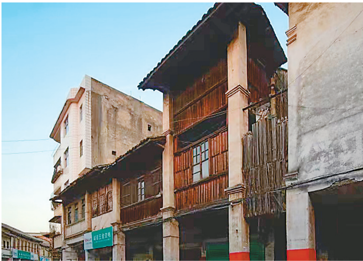
近年来，一些来自中小城市和乡镇的优秀建筑瑰宝被发掘出来并通过“建筑遗产”的方式进入价值研究和保护范围。入选本次推介项目的江西龙南解放街是1910年建成的骑楼建筑。图为江西龙南解放街（黄道生骑楼老宅）。
