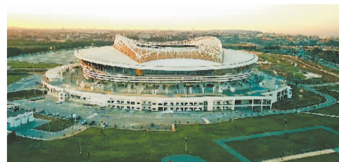
纳尔逊·曼德拉体育场。中铁建工集团北非区域总部供图
