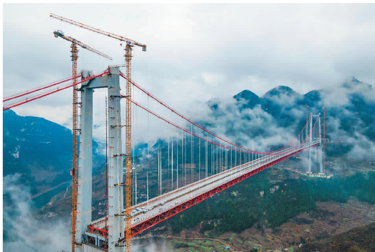
目前,位于贵州省遵义市仁怀市、桐梓县交界处的金桐高速桐梓河特大桥主体已基本建设完成,从远处看去犹如一条“钢铁巨龙”,蔚为壮观。大桥全长1422米、主跨965米,桥面距离河谷约365米,是全球首个高低塔采用无桩基础设计的大跨度悬索桥。 贾智摄(人民图片)
