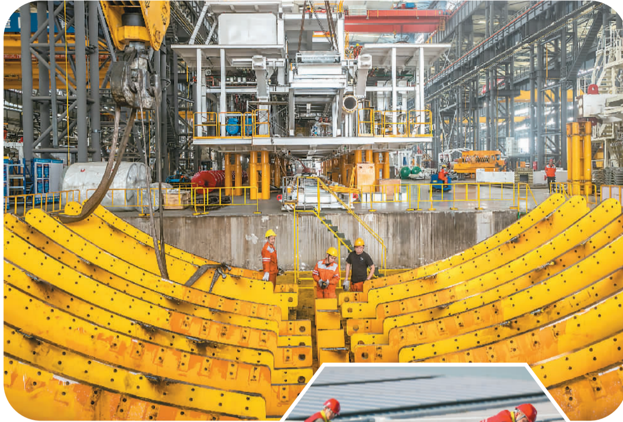
▲位于广东省佛山市伦教镇的 中铁华隧联合重型装备有限公司车 间一派繁忙景象，工人正在对盾构 机部件进行建造和调试。 王美燕摄（人民视觉）
