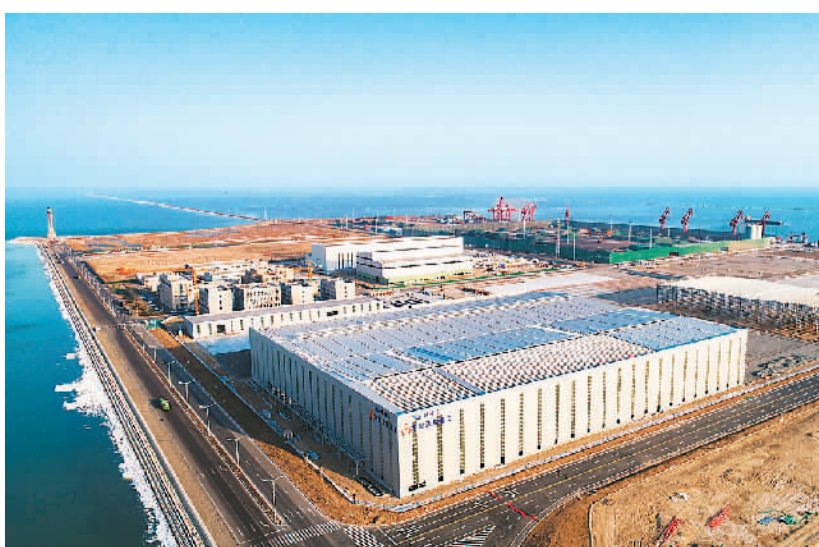
山东东营经济技术开发区依托港口及腹地土地储备优势，规划建设东营海上风电装备产业园。目前，已签约落地项目23个，总投资243亿元，海上风电装备产业链条逐步成型，产业集群初步成型。图为正在建设中的东营海上风电装备产业园。杨胜男摄（人民视觉）
