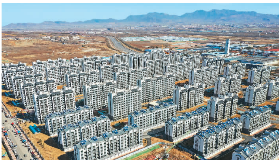
2月21日，山东省济南市章丘区重点民生工程山阳片区旧村改造项目首批3583户回迁居民喜搬安置房。山阳片区旧村改造项目由中铁建工集团有限公司承建，总建筑面积达108万平方米，可提供安置房9411套，项目将于2023年底全部交付使用。图为首批交付的安置房新居。新华社记者 朱 峰摄
