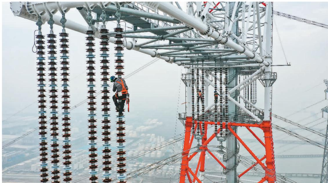
2月20日, 在385米世界最高输电铁塔——江苏凤城至梅里500千伏输电线路工程长江大跨越现场, 施工人员正在百米高空进行走线验收, 全面检查施工工艺, 确保工程以“零缺陷”的状态投运。该工程建成投运后, 可将长江北岸的新能源不断送往江南, 满足约800万户家庭的日常用电需求。
