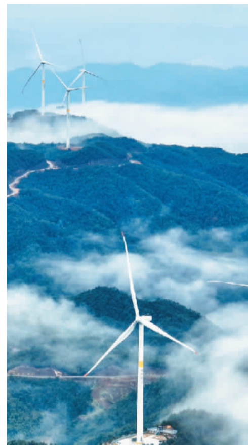
上图：位于广东省韶关市新丰县的金竹风电场，一座座风力发电装置耸立在高山之巅，在云雾间若隐若现，宛如仙境。 付海燕摄（人民图片）
