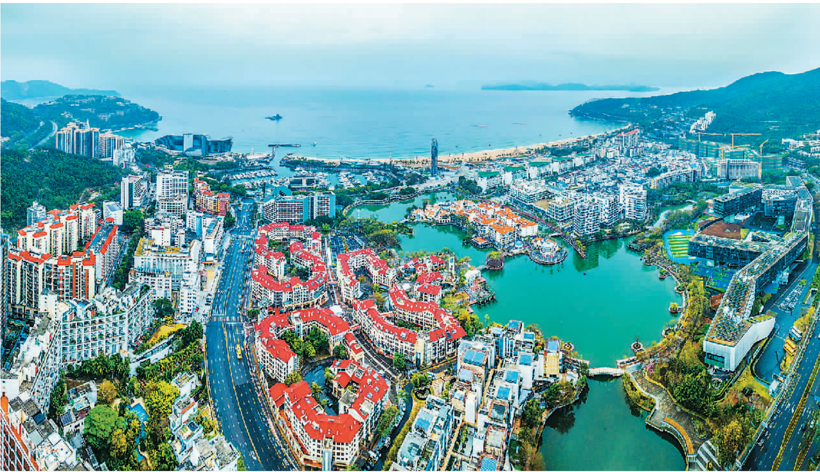
广东省深圳市盐田区梅沙街道近来积极探索近零碳排放试点工作，广泛开展培植增绿和生态修复治理，充分利用生态化处理技术治污减排，消除餐厨垃圾和水污染，通过“生态屋顶”和提升“绿电”使用比例，达到微气候调节、雨水调蓄等，大大减少能耗，建设成人与自然和谐共生的零碳样本。 胡学军摄（人民视觉）
