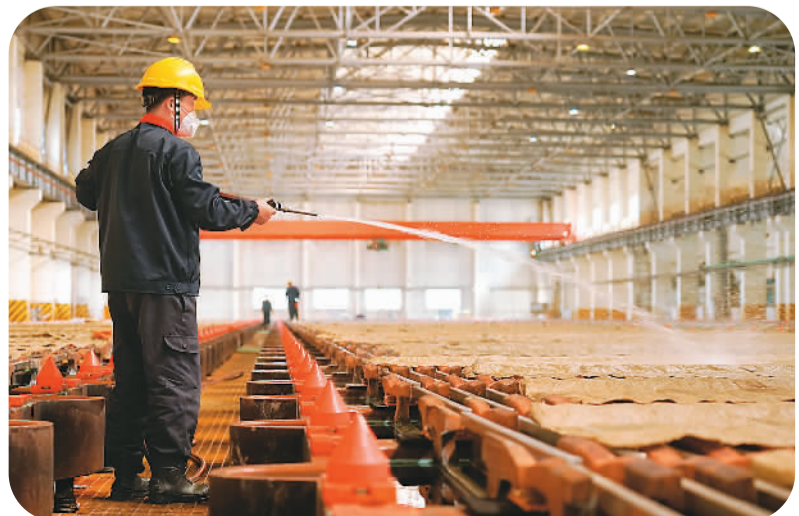
春节后，青海省西宁市甘河工业园区的企业开足马力，争分夺秒推进生产进度。图为2月8日，在青海铜业有限责任公司，工作人员在进行洗水作业。新华社记者 解强摄
