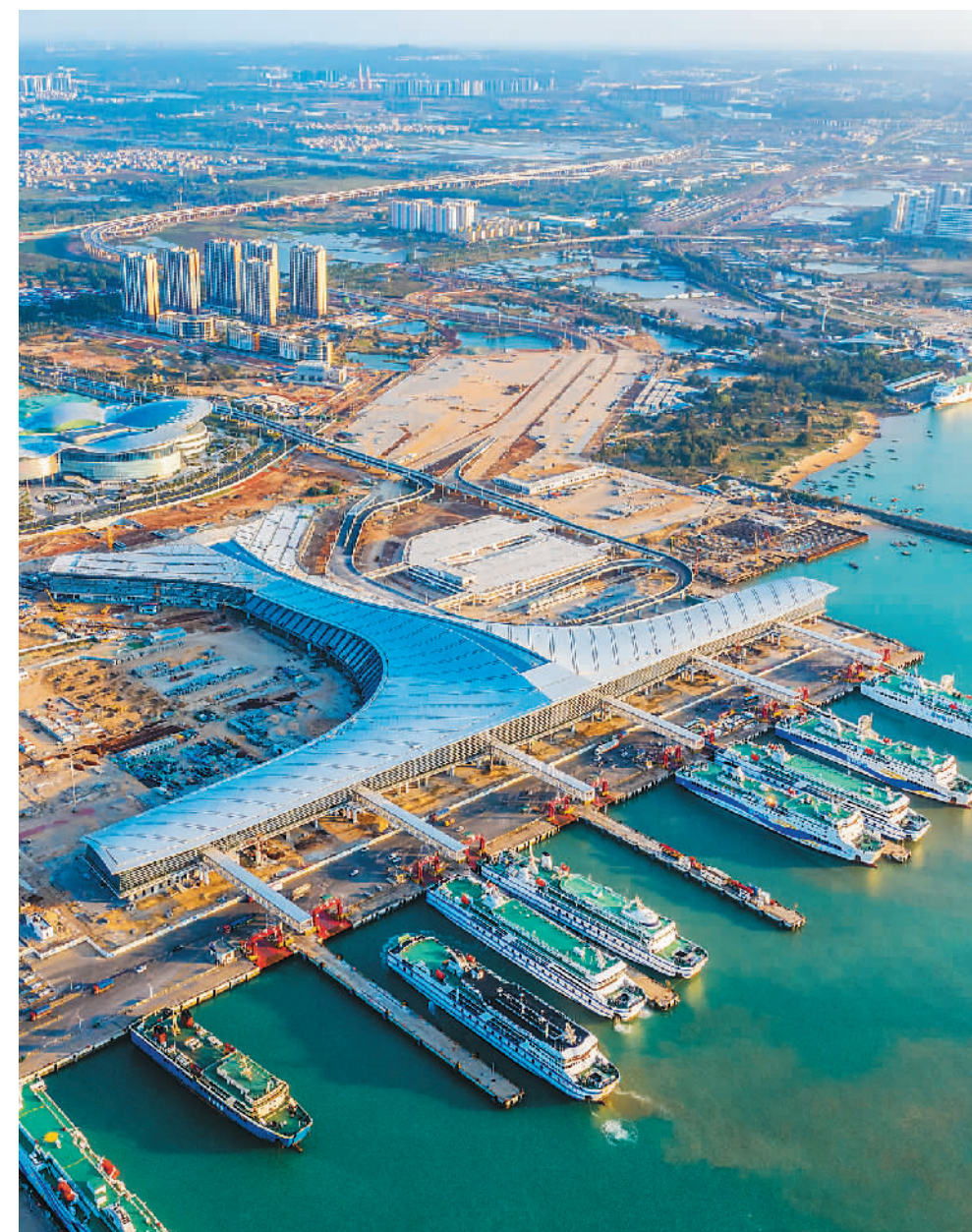
海南省海口新海滚装码头客货综合枢纽站工程项目幕墙施工已经完成95%, 目前该项目主体结构已竣工。建成后, 将实现游客过海“零换乘”, 大大提高海口新海港的服务水平, 助力海南自由贸易港建设。图为2月7日鸟瞰海口新海滚装码头客货综合枢纽站工程项目。 石中华摄(人民图片)
