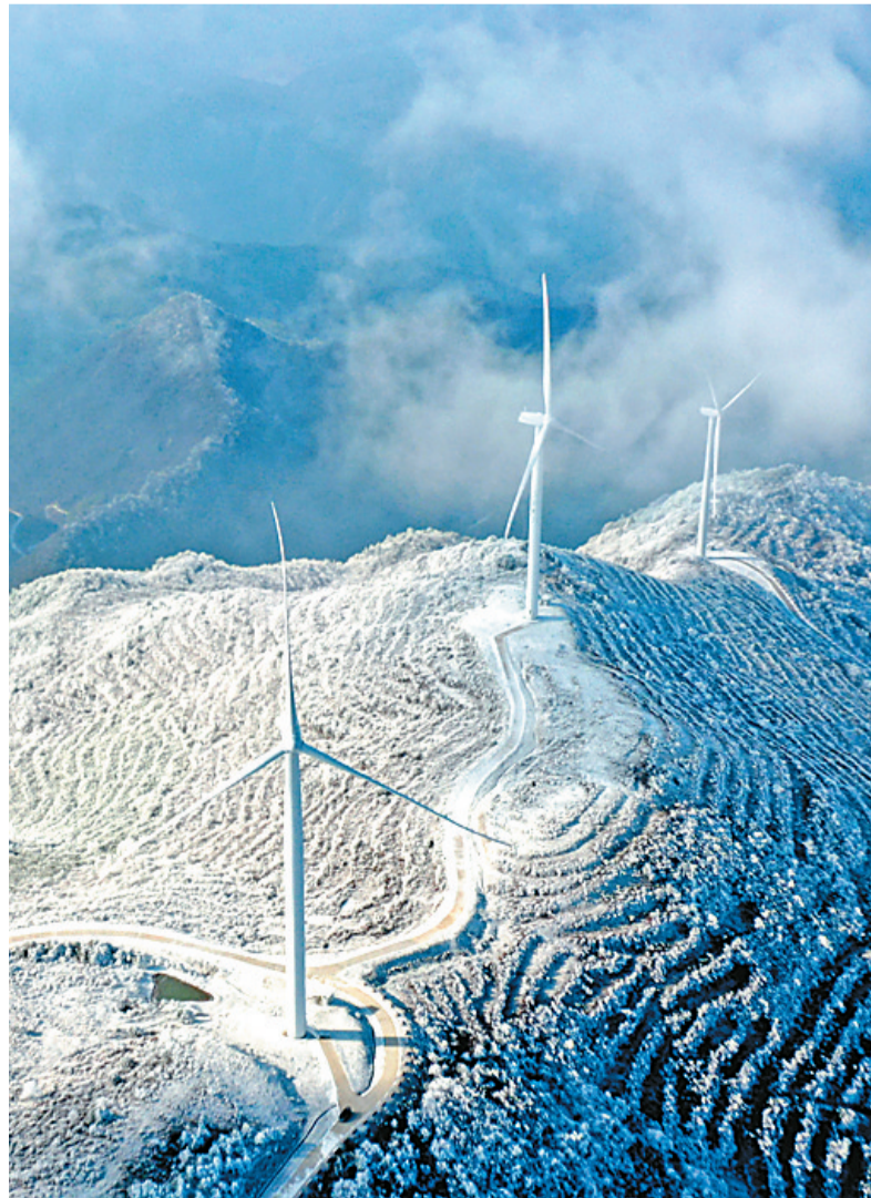
浙江省金华市磐安县坚持绿色发展理念，推进高山风能、光伏发电等发展，助力低碳减排和乡村振兴。图为日前，磐安县龙源电力风电场的风电机组在雪后运行。
