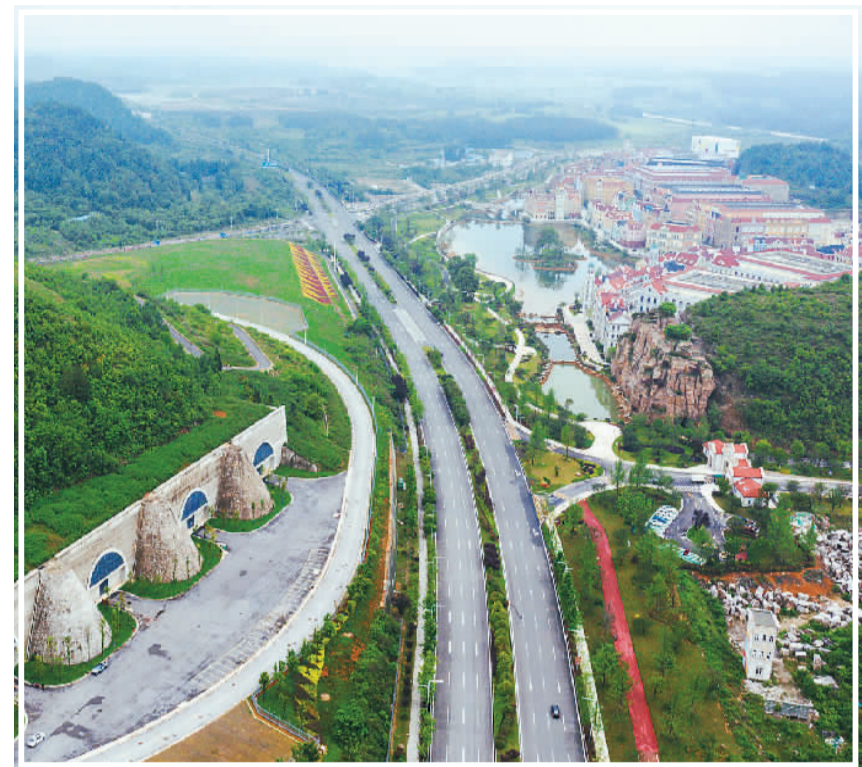
贵安新区华为云数据中心（以道路为界右侧）和腾讯贵安七星数据中心（左侧）。新华社记者 欧东衢摄
