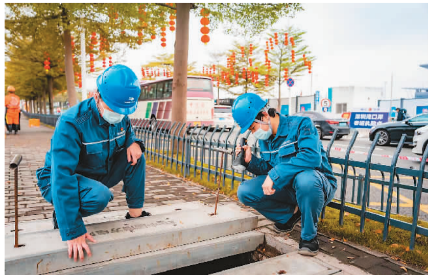
近日，内地与香港多个口岸开始分阶段有序恢复人员正常往来。为保障口岸电力电力系统正常运作，南方电网深圳供电局对所辖多处口岸的供电设备开展巡检，确保运行平稳。图为工作人员正在对深圳湾口岸沿线电缆沟开展专项巡视。黄海鹏摄
