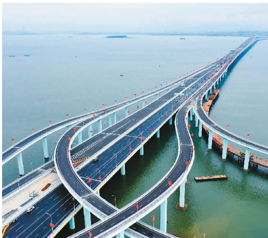
1月17日, 福建省首座预制装配化跨海大桥——厦门翔安大桥主桥正式通车。大桥全长约12公里, 其中跨海桥梁长约4.5公里, 设计时速80公里。图为俯瞰厦门翔安大桥。 新华社发
