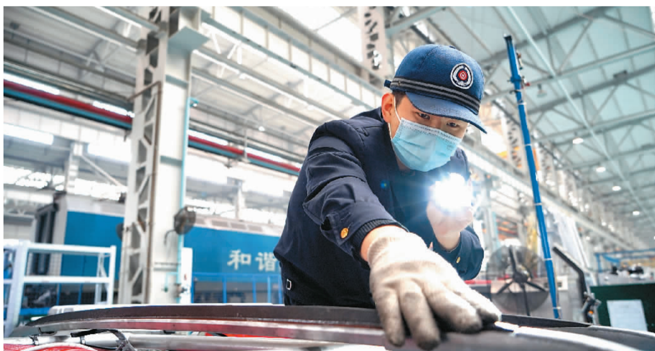
▲在成都机务段和谐型大功率机车检修基地，检修人员对和谐型机车的高压回路进行检修作业，为春运保驾护航。
