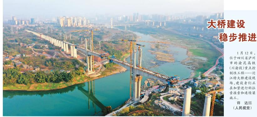
1月12日, 位于四川省泸州 市的渝昆高铁 (川渝段)重点控 制性工程——沱 江特大桥建设现 场,建设者们正 在加紧进行斜拉 索挂索和连续梁 施工。
