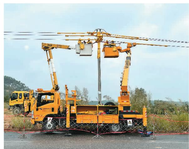
近年来，广西钦州市持续对电网进行升级改造，建设安全可靠、节能环保、技术先进、管理规范的新型供电体系。新年伊始，南方电网广西钦州供电局即启动电力设施特巡特维、年检消缺工作，打造“检修不停电、故障少停电”的高可靠性配电网。图为该局工作人员对10千伏线路进行直线杆改为耐张杆作业。
