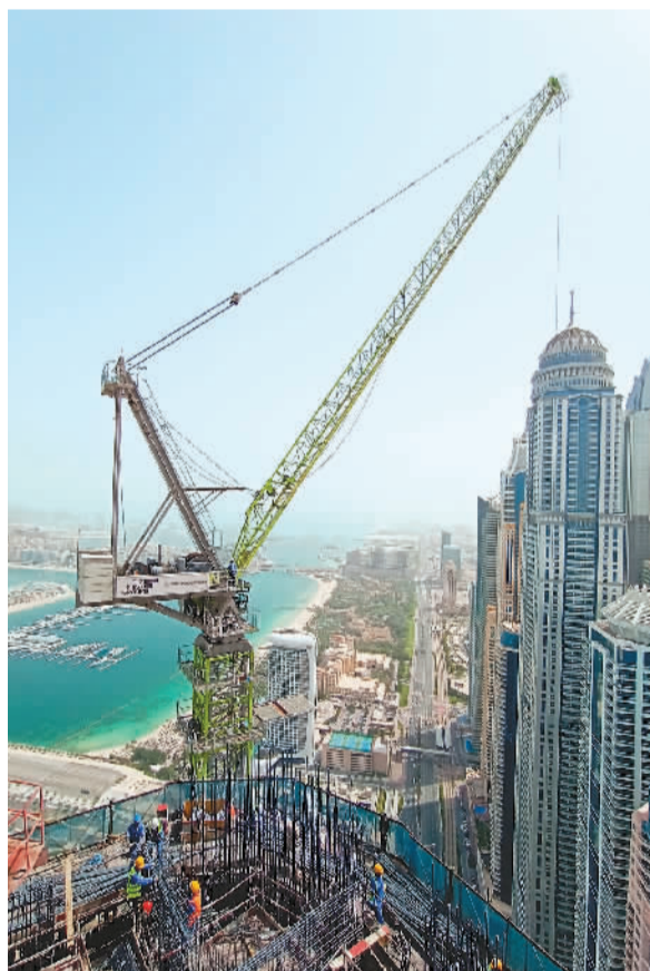
中联重科L250-20大吨位动臂塔机在迪拜蓝天酒店项目建设现场。受访企业供图
