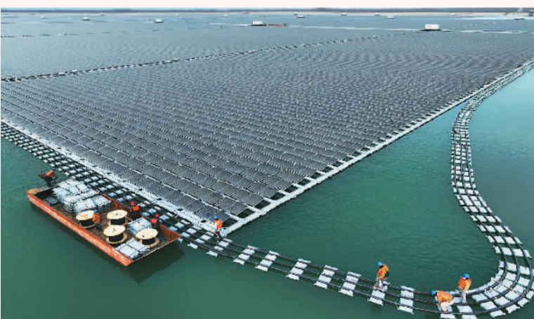
▲近日在国家能源集团山东电力有限公司聊城发电运营分公司循环水水库漂浮式光伏发电项目建设现场，工人进行组件铺设的最后安装。
