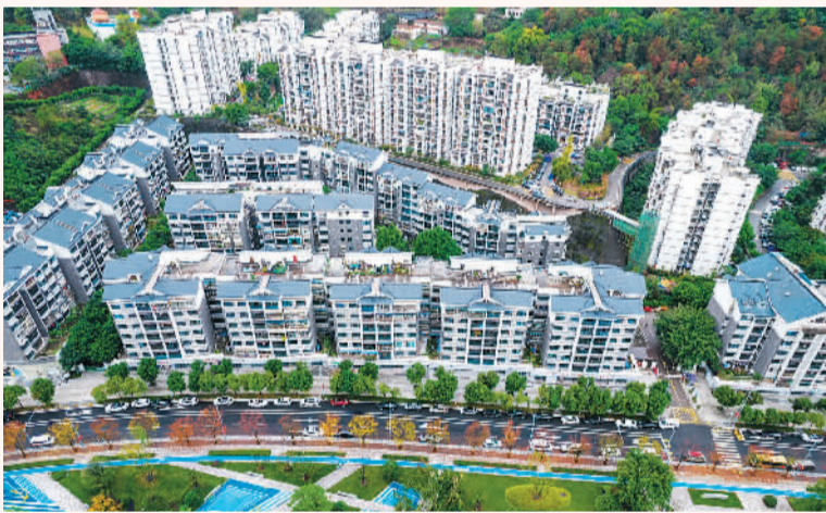
▲重庆市大力推进老旧小区改造，增建配套设施，完善居住功能。图为重庆市南岸区峡口镇一处完工的城市更新项目。郭旭摄（人民视觉）
