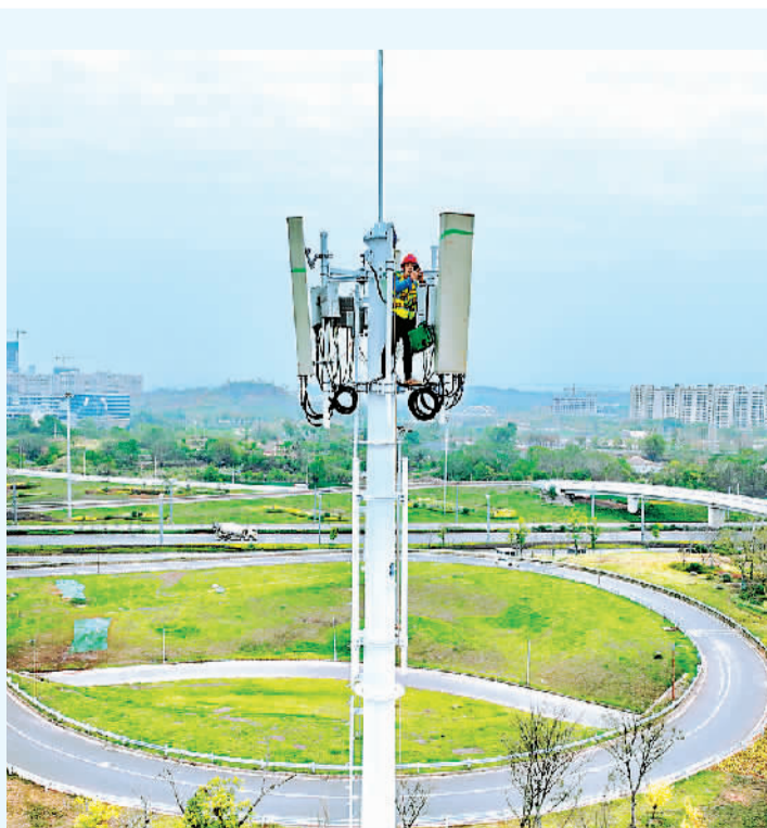
江西省赣州市大力推进5G通信网络基础设施建设,加快5G应用推广,提升信息化服务水平,为服务乡村振兴和数字经济发展提供有力保障。目前,赣州市实现主要街道、热门景点的移动5G网络覆盖,群众能更好地享受到5G移动通信技术服务。图为移动通信技术人员在赣州蓉江新区赣南大道5G基站测试5G网络信号。 朱海鹏摄(人民图片)
