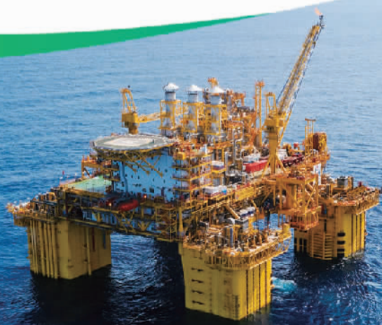
“深海一号”能源站核心装备由海洋石油工程（青岛）有限公司建造
