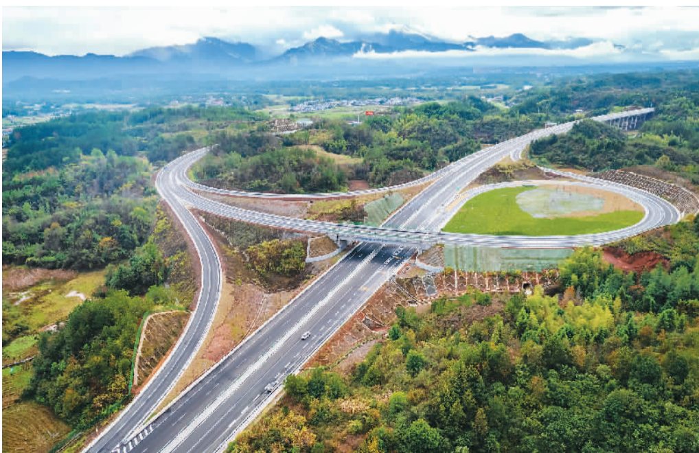
11月28日，湖南省首条智慧高速——湖南平江（湘赣界）至益阳高速公路全线通车运营。平益高速大量运用大数据、物联网、人工智能、车路协同等技术，通过智慧综合运营管理平台等智慧应用，进一步保障交通安全和通行效率。新华社记者 陈思汗摄
