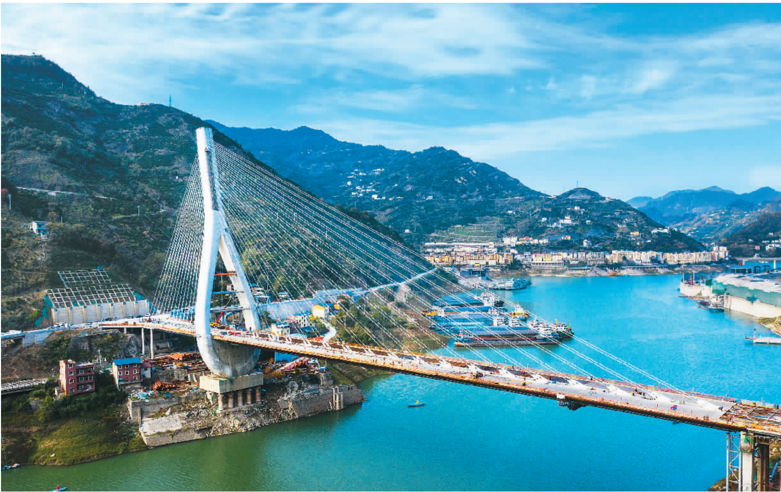
近日,湖北省宜昌市的香溪河大桥正在抓紧建设,琵琶形独塔斜拉桥的主体结构已经成形。香溪河大桥是连接宜昌市兴山县峡口镇和秭归县乐平里区域的重点交通枢纽工程,塔身采用顺桥向倾斜十度的琵琶造型。项目预计明年建成通车。图为建设中的香溪河大桥。 郑坤摄(人民视觉)
