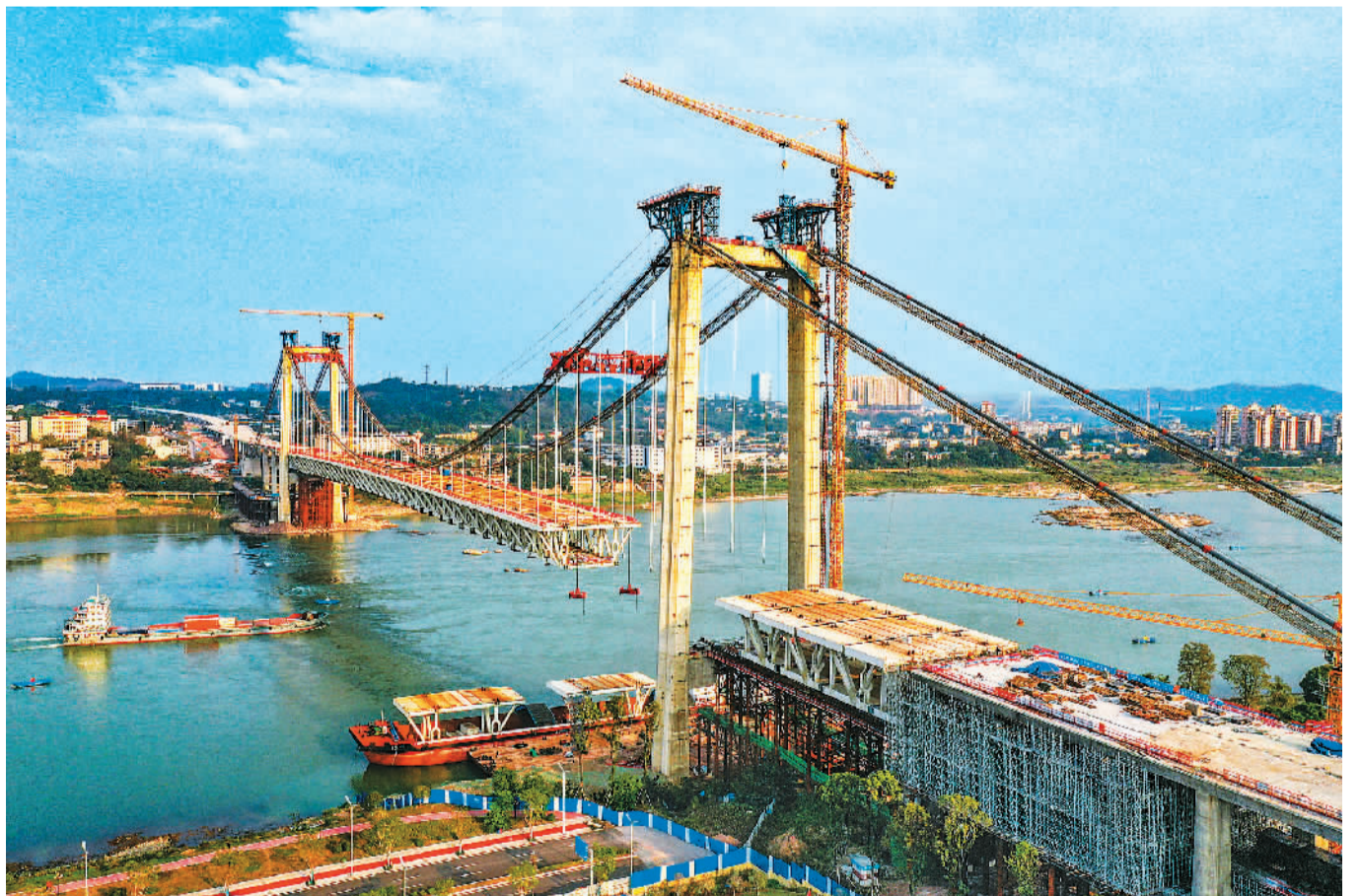
近日，位于四川省泸州市的泸州长江二桥正在有序建设，工人们抓紧晴好天气，实施钢桁梁吊装作业。
