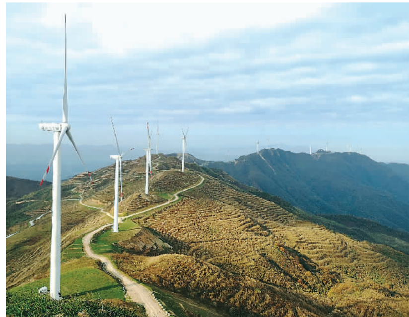
贵州省铜仁市石阡县立足资源禀赋和生态优势，全力推动风、光、水等新能源产业发展。南方电网铜仁石阡供电公司为企业高效接入并网服务，为经济社会发展提供源源不断的绿色能源。图为平均海拔1400米以上的石阡大顶山，风力发电机与山林相映成景。杨明勇摄（人民视觉）
