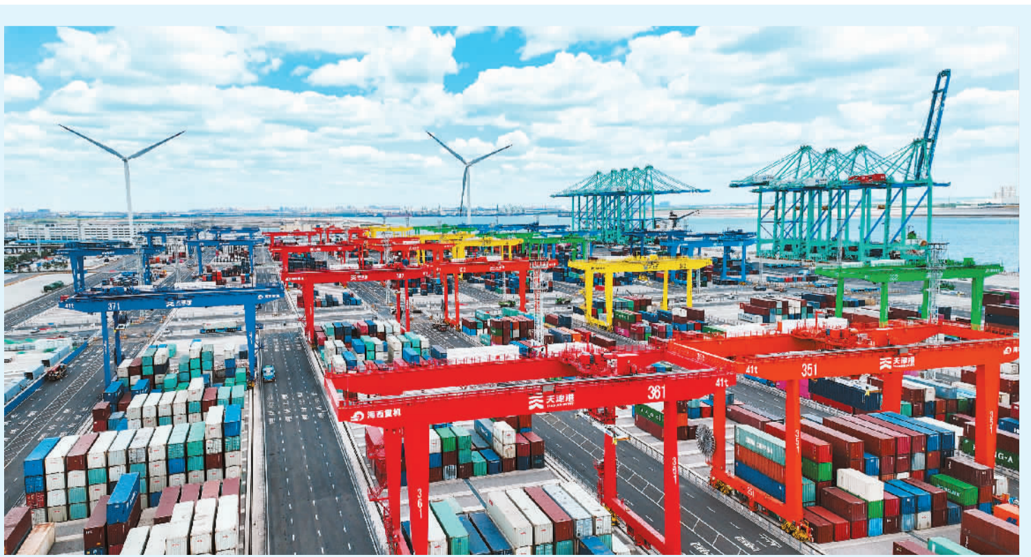
▲天津港北疆港区C段智能化集装箱码头。夏德松摄
