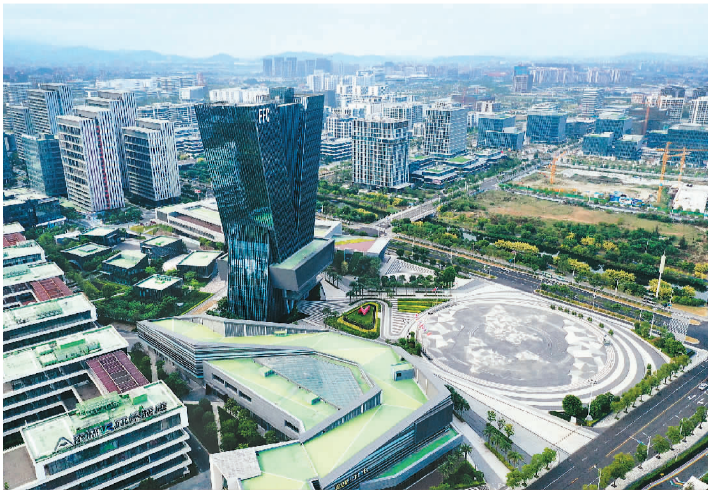
福建省福州市长乐滨海新区东湖数字小镇高楼林立，基础设施建设持续推进，一片欣欣向荣。近年来，当地从城市规划、税务、金融等方面持续下功夫，为东湖数字小镇成长壮大创造条件，助推福州经济发展。图为近日航拍的东湖数字小镇。王建锋摄（人民视觉）
