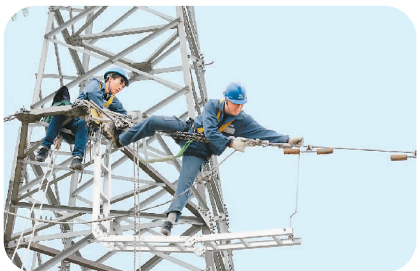
党的二十大代表、南方电网贵州兴义供电局输电管理所综合数据班高级作业员龙福刚,在工作中始终如一用行动和责任维护着电网的安全稳定运行。图为日前龙福刚(右)带领徒弟在110千伏高压输电线路开展检修工作。 卢关文摄
