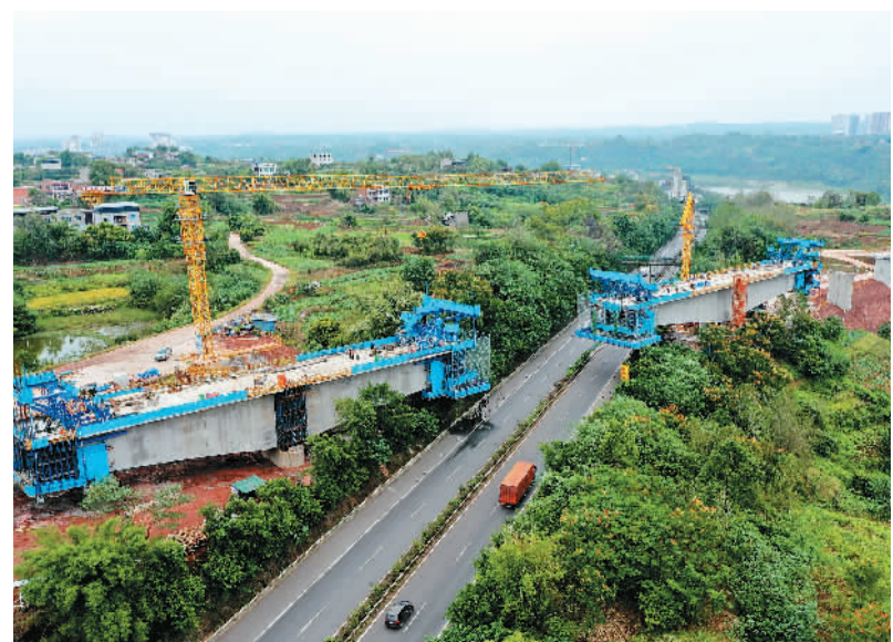
10月7日,在渝昆高铁沱江特大桥跨厦蓉高速连续梁建设现场,中铁四局建设者全力以赴抢抓施工进度。许达摄(人民视觉)
