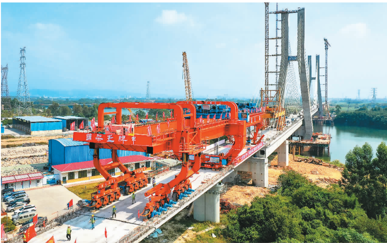
近日，中铁五局承建的广汕铁路铺架施工最后一孔900吨箱梁成功架设在广东广州增江特大桥桥墩上，标志着全线箱梁架设完成。设计时速350公里的广汕铁路全长206.2公里，途经广州、惠州、深汕合作区、汕尾，全线预计2023年建成通车。通车后，广州到汕尾运行时间将由现在的2小时左右缩短至40分钟左右，将有力助推粤东地区加快融入粤港澳大湾区。
