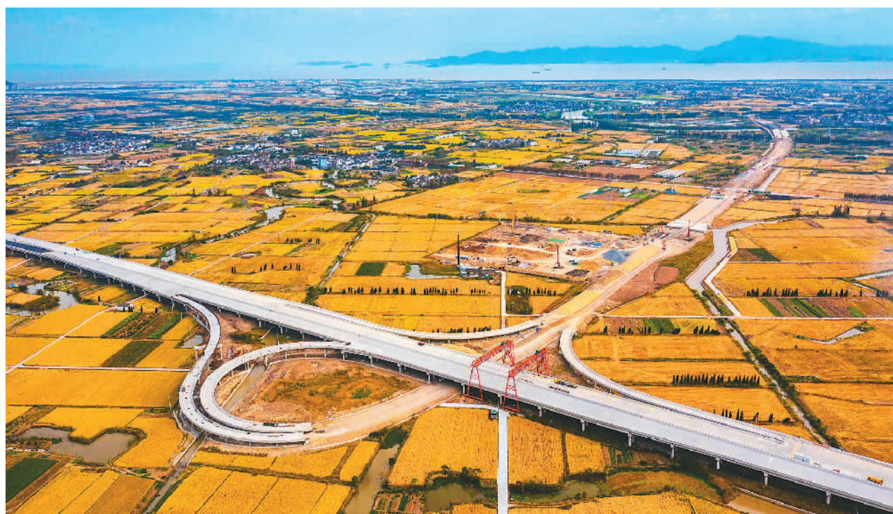
图为建设中的浙江省宁波市象山湾疏港高速跨海互通工程，如同一条巨龙盘卧在金色的田野上，与碧水青山、河流村庄相互映照，构成一幅壮美的交通画卷。胡学军摄(人民视觉)
