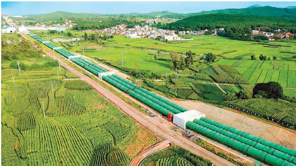
近来, 滇中引水工程楚雄观音山压力钢管倒虹吸项目建设顺利推进。该项目由云南省滇中引水建管局管理, 总干渠全长9.777公里, 设计流量每秒100立方米。滇中引水工程是国务院确定的重大水利工程之一, 建成后可以从水量相对充沛的金沙江干流引水至滇中地区, 惠及人口达1112万人。
