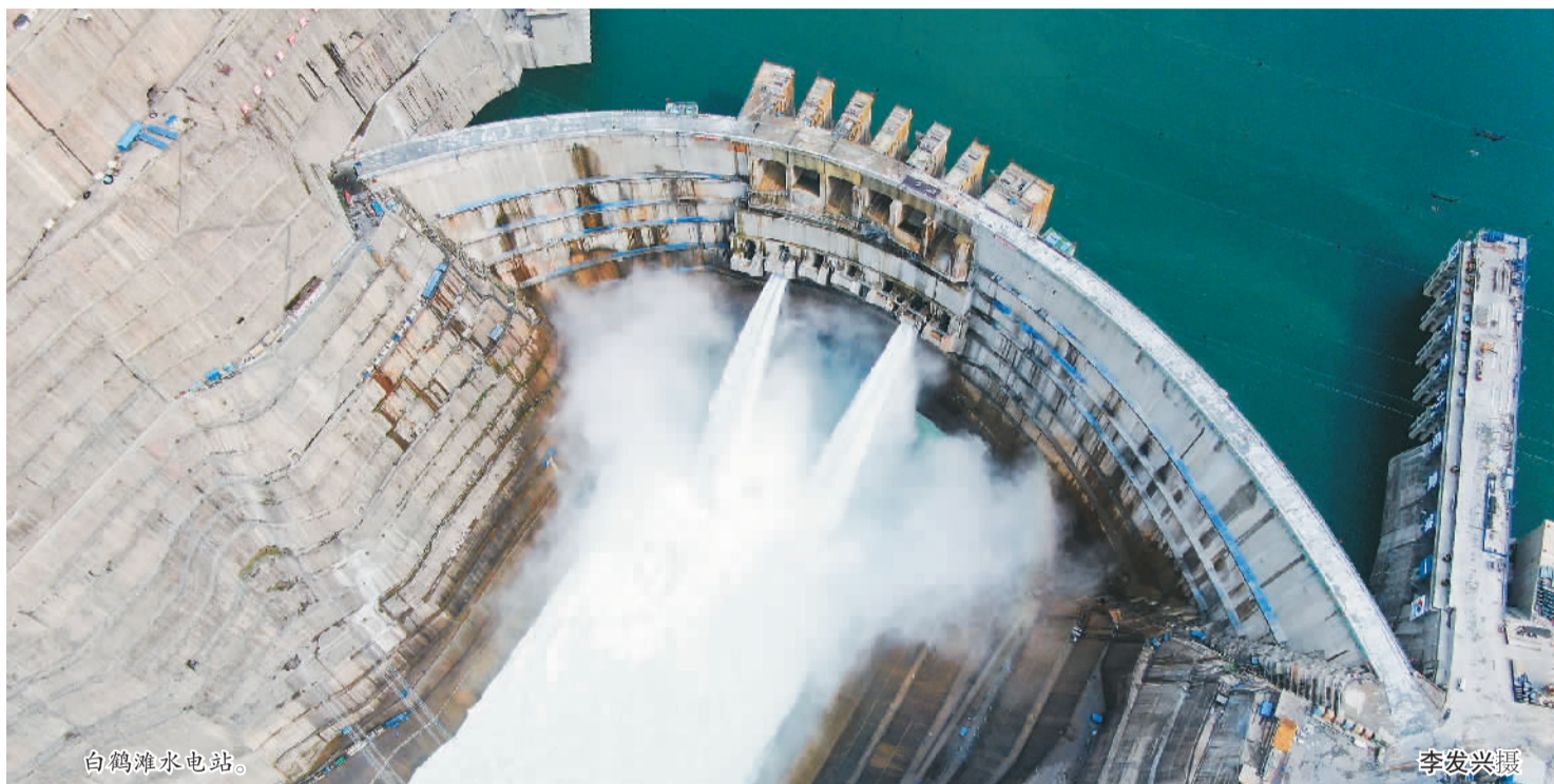
白鹤滩水电站。
