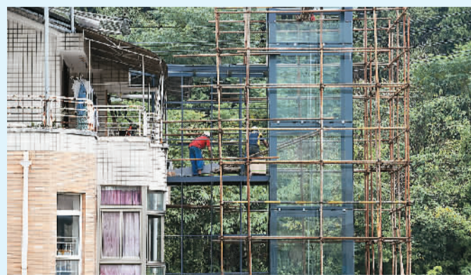
9月9日，贵州铜仁市一老旧小区正在加装电梯。 陈勇摄（人民视觉）
