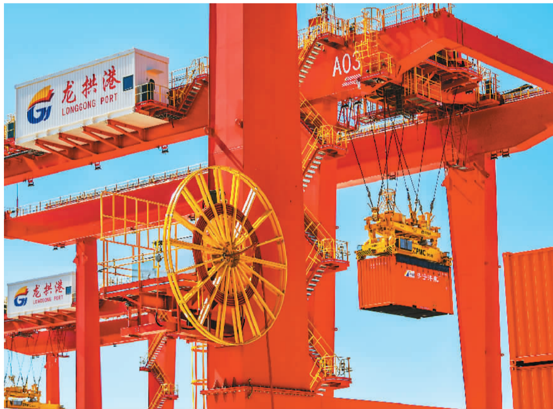
位于大运河山东段的内河港口济宁港航龙拱港近年来不断推进内河港口智慧化建设,可实现年集装箱吞吐量八十多万标箱、年货物吞吐量超两千万吨。图为龙拱港港区内的吊车正在作业。 杨国庆摄(人民视觉)
