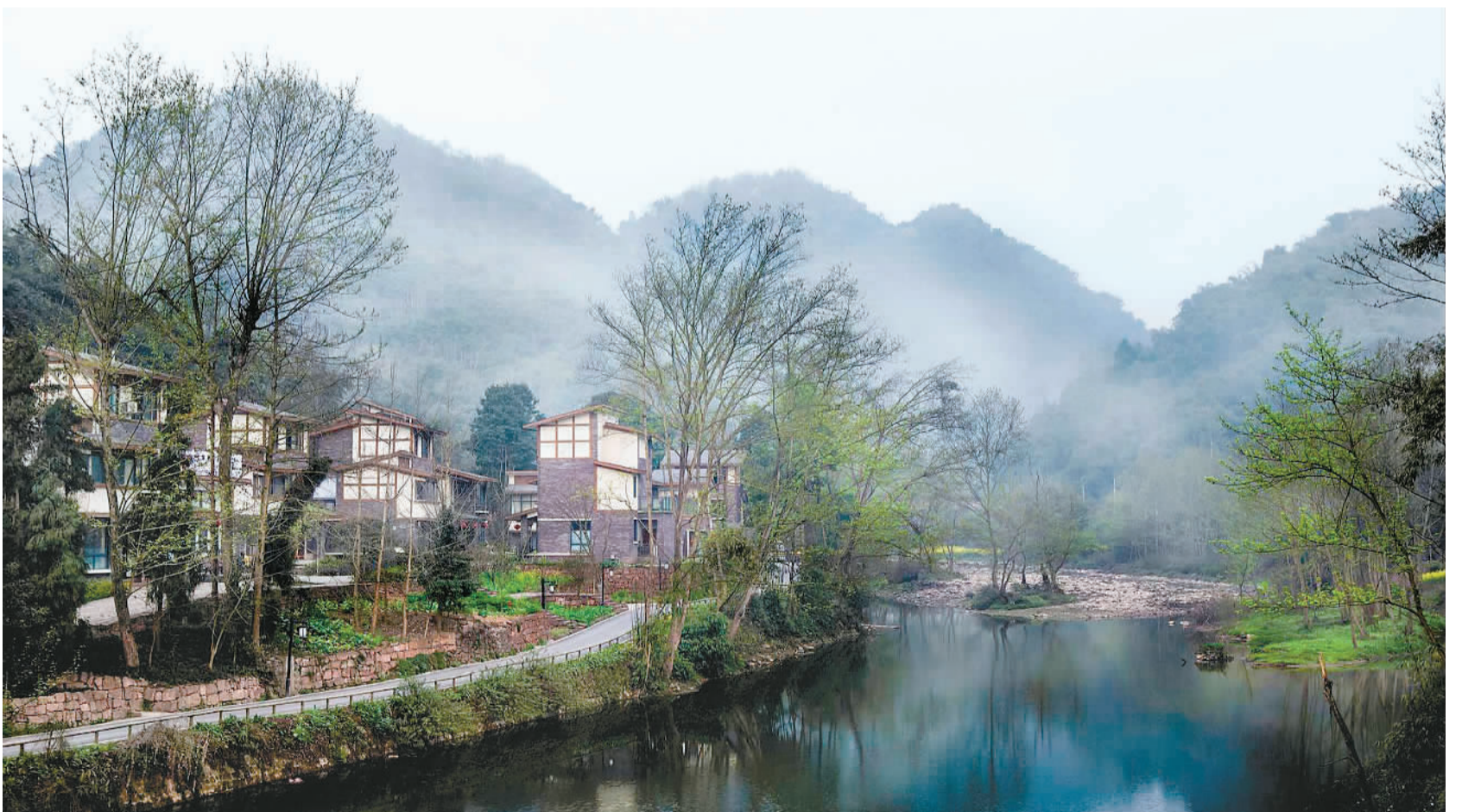
图为四川省平乐县中夹关镇周河扁聚居点建设实景。
