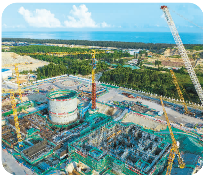
位于海南昌江的玲龙一号建设工地。
