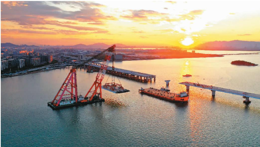
9月12日，福建省厦门市第二东通道——翔安大桥主桥成功合龙。翔安大桥项目西起枋枋路和金尚路交叉口，向东以连续梁桥跨越厦门东侧海域，终于翔安大道，全长约12公里，其中跨海桥梁（海中区）长约4.5公里，主线按双向8车道高速公路标准建设，设计时速80公里。图为中交二航局参建的翔安大桥主桥合龙现场。
