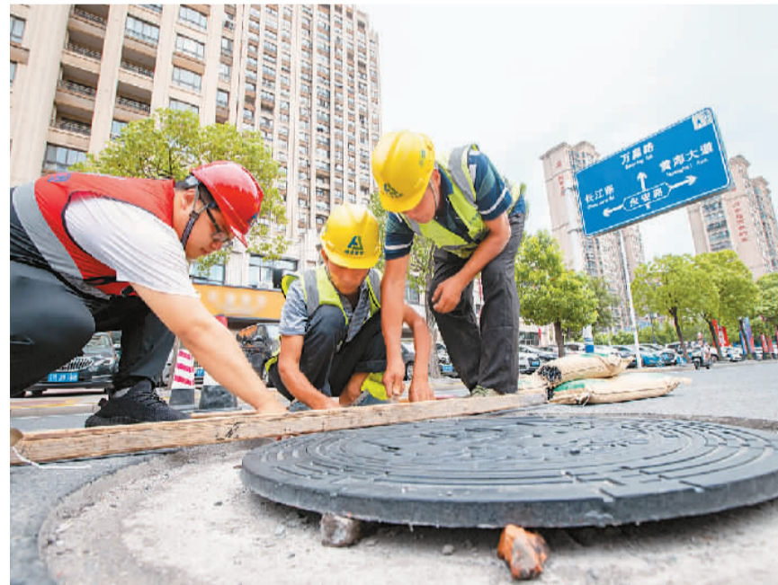
江苏省海安市城建集团的工人正在城区安平路安装新窨井盖。瞿慧勇摄（人民视觉）
