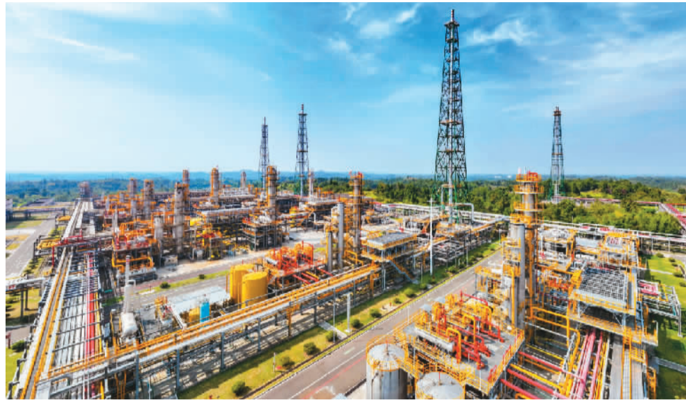
图为位于四川省遂宁市安居区的中石油遂宁天然气净化厂。刘昌松摄（人民视觉）
