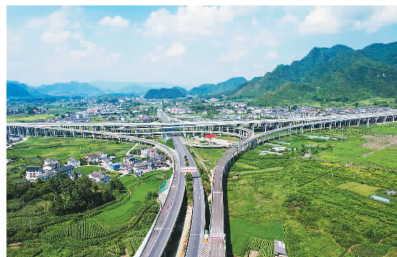
日前, 位于贵州省遵义市的兰海高速重遵扩容工程蒲场特大桥竣工。蒲场特大桥位于重遵扩容高速公路蒲场枢纽互通与绥遵高速十字枢纽交叉处, 是兰海高速重遵扩容项目14标段控制性工程, 全长1.61公里。图为蒲场特大桥。
