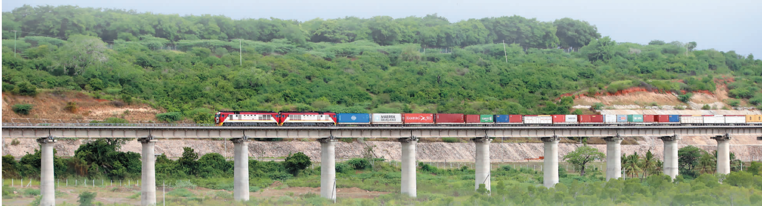
▲ 因途经内罗毕国家公园和察沃国家公园等野生动物保护区，蒙内铁路根据沿线野生动物迁徙种类和迁徙路径以及活动习性，专门设置了14个野生动物通道，线路两侧设置隔离栅栏，避免动物通过时与列车相撞。铁路还在小河沟等低洼处设置涵洞，方便斑马等动物饮水。这些细心的设计引得外媒称赞“中国在非洲造的铁路，连长颈鹿都很满意”。图为肯尼亚蒙巴萨红树林旁，一列货运列车行驶在蒙内铁路线上。 新华社记者 董江辉摄
