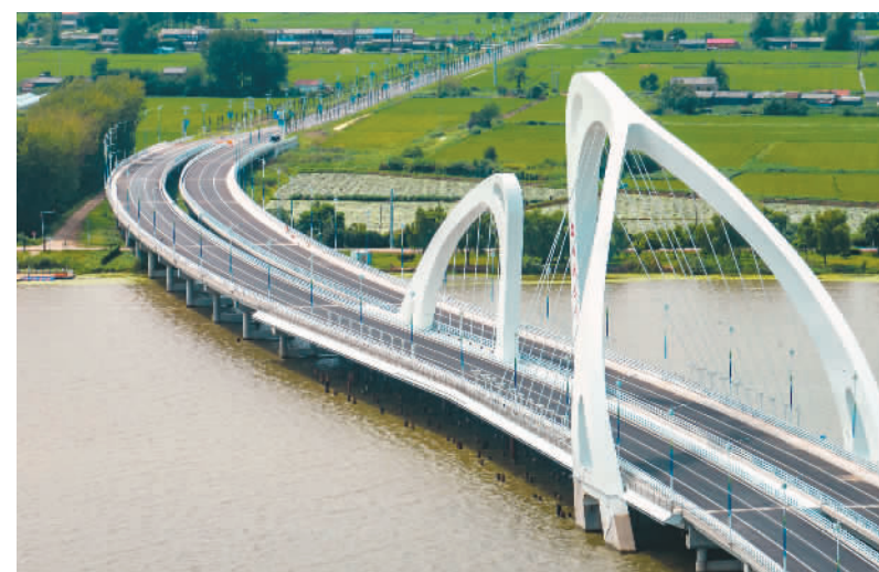
8月28日,江苏省淮安市白马湖上“鱼跃龙门”式的白马湖大桥新亮相。白马湖大桥是白马湖大道关键节点工程,全长1033米。目前,大桥已具备通车条件,即将举行竣工验收。 贺敬华摄(人民图片)
