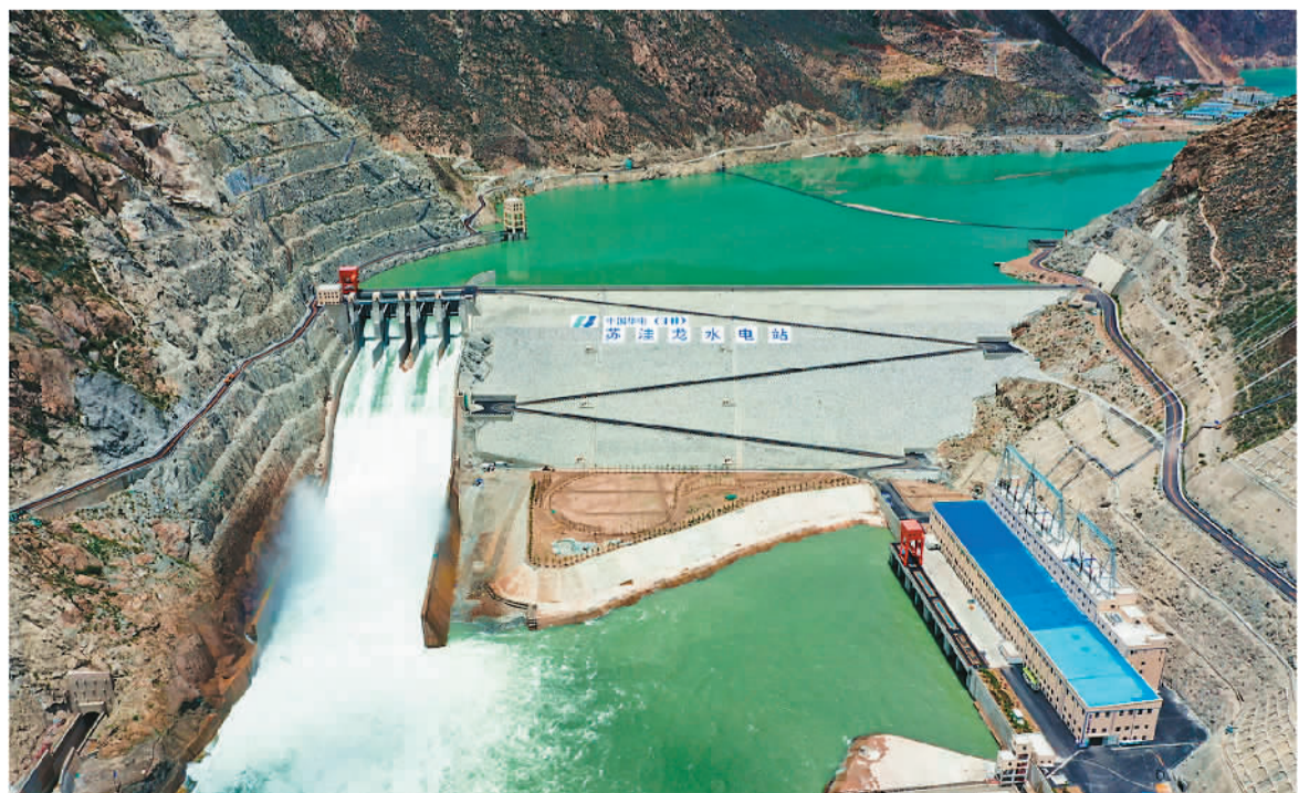
金沙江上游苏洼龙水电站 3号机组投产发电
