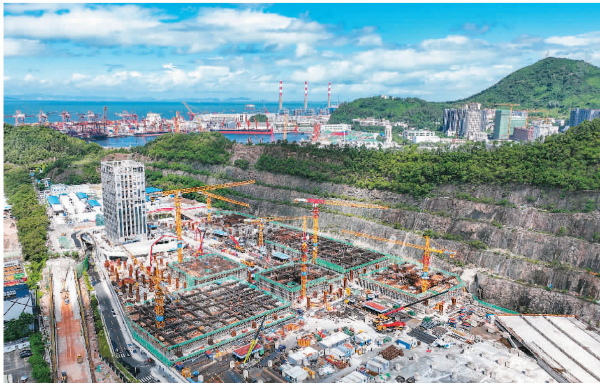
近日,位于广东深圳蛇口的地铁12号线赤湾停车场主体工程全部完工,将于年底投入运营。据介绍,该工程是深圳目前正在建规模最大的地铁停车场,建成后将承担地铁12号线部分列车的停放、列检等工作。图为深圳地铁12号线赤湾停车场建设现场。 王美燕摄(人民视觉)
